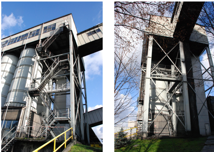
Rys. 4. Widok klatki schodowej.
