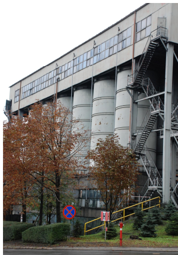
Rys. 5. Widok baterii silosów i hali filtrów (nad baterią).
